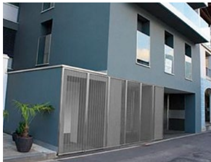
R&R 70X3 Edificio Residenziale, Switzerland
